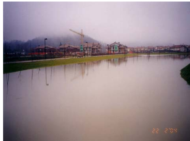
Figura 5.2 - Volume di invaso ricavato in fregio al corso d'acqua ricettore, in periodo secco (a sinistra) e durante una piena (a destra)
