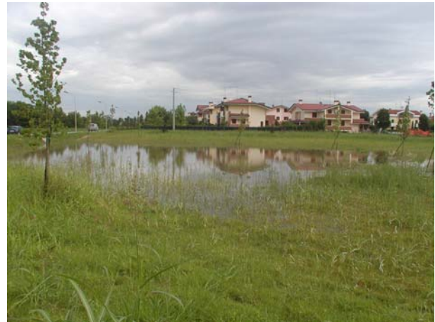
Figura 5.1 - Volume di invaso ricavato tramite depressioni in aree verdi, in periodo secco (a sinistra) e durante una piena (a destra)
