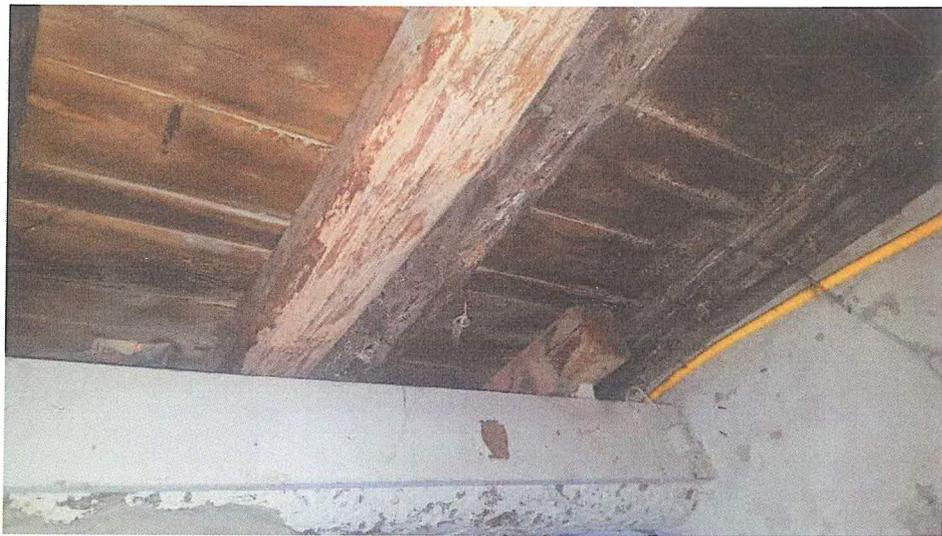
06. travi del solaio di copertura, con evidenti necessità di manutenzione.
